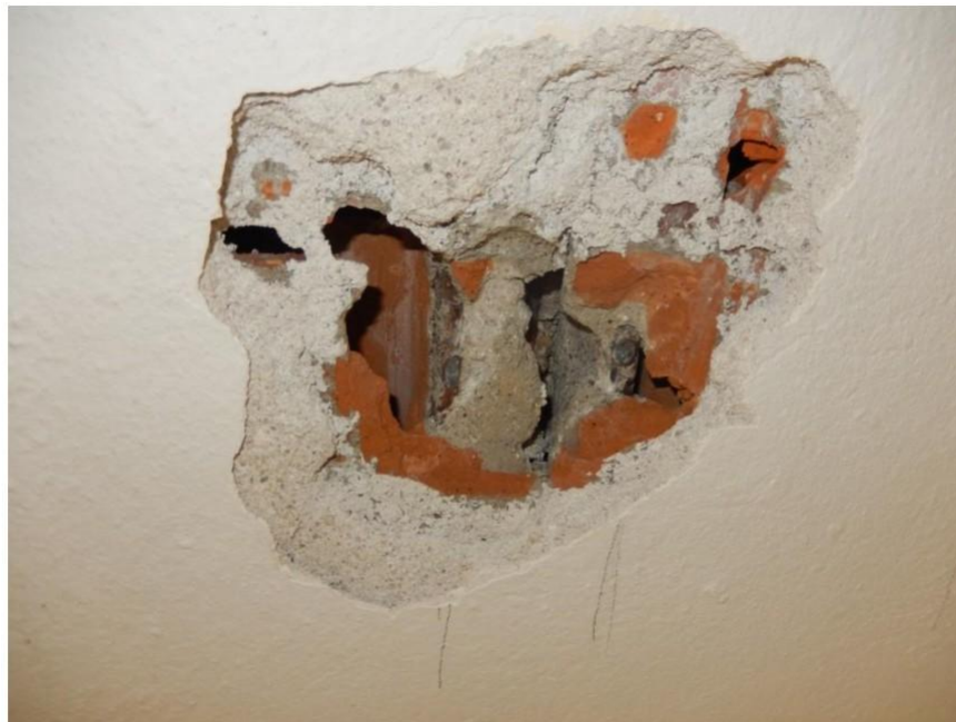
Fotografia 25 - Apertura breccia per rilievo solaio (SolC01)
