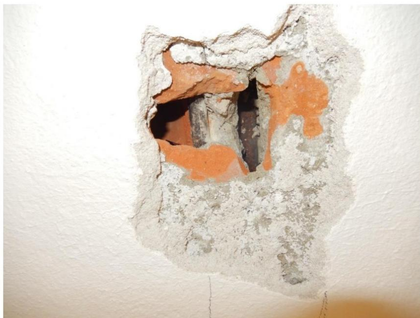
Fotografia 24 - Apertura breccia per rilievo solaio (Sol101)
