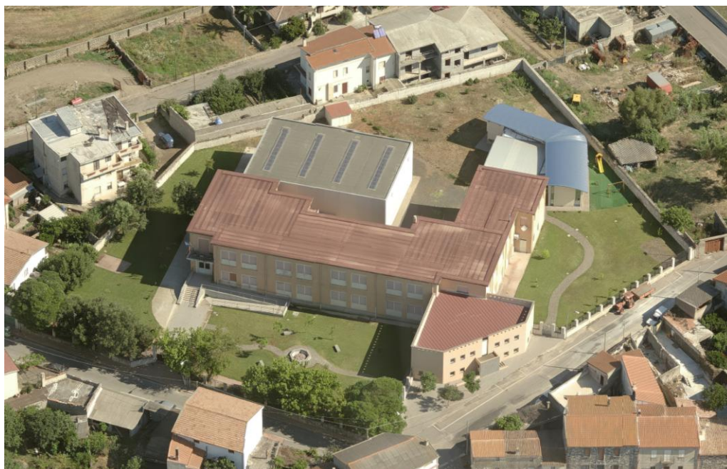
Vista aerea del complesso prima che venisse realizzata nel 2015 la copertura a falde sul corpo A
