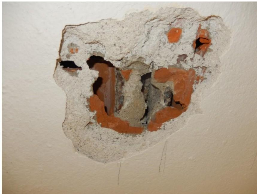
Fotografia 25 - Apertura breccia per rilievo solaio (SolC01)
